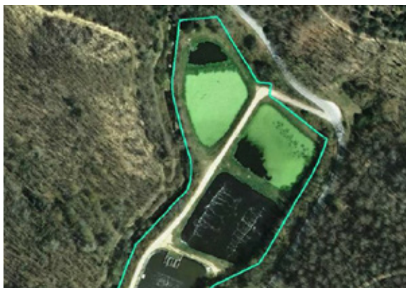
Instalación dentro de espacio natural protegido.
